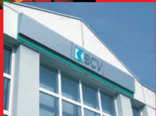
Bandeau lumineux avec incrustation de plexiglas
