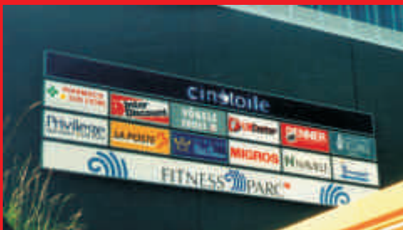
Groupe de caissons lumineux de grands formats contre façade
