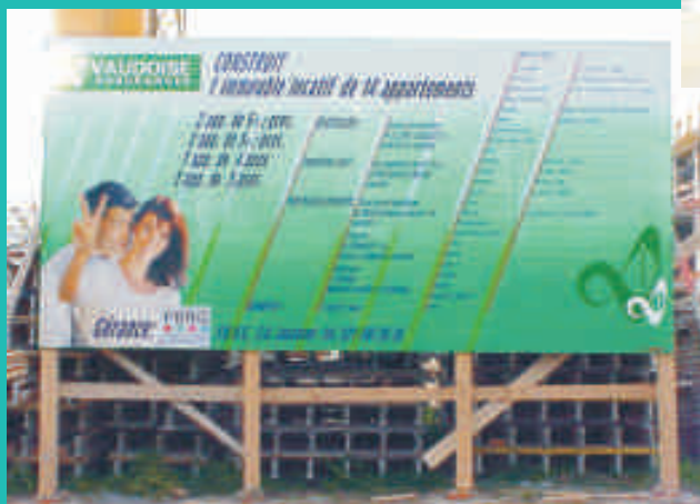
Panneau de chantier
